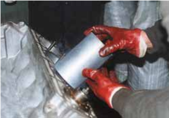
Чтобы установить гильзу, охлажденную в жидком азоте, в гнездо блока, никаких усилий не требуется.
